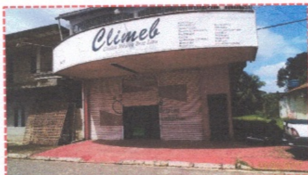
Foto 01: Fachada Principal do imóvel
