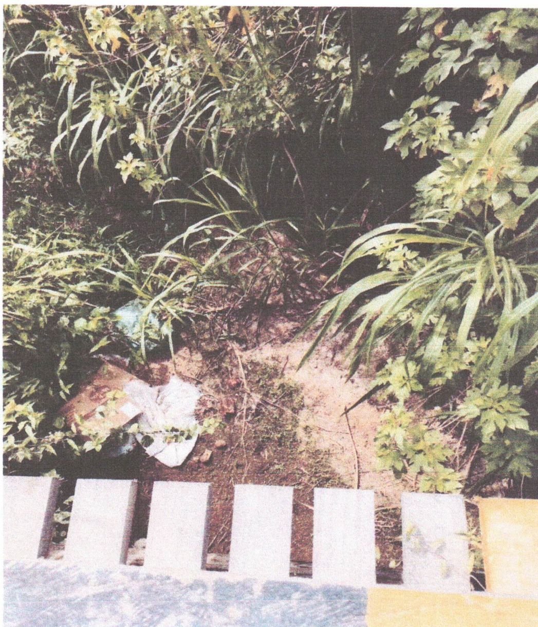
Figura 2: Ponte sobre rio no município de Santa Luzia do Pará.
