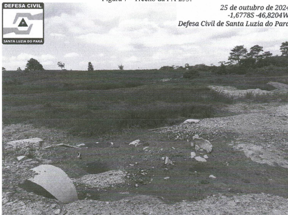
Figura 7 - Trecho da PA 253.
