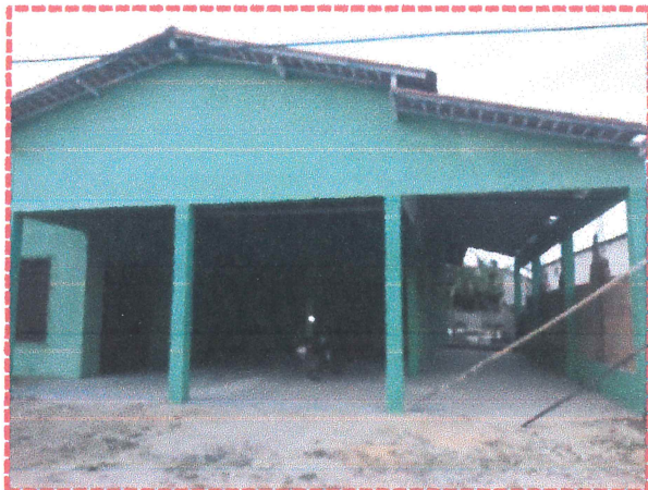
Foto 01: Fachada principal do imóvel
