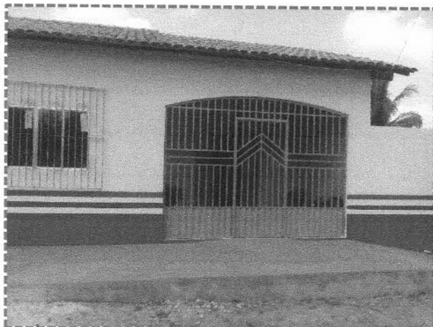
Foto 01: Fachada principal do imóvel
