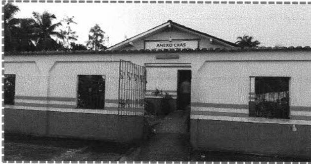
Foto 01: Fachada principal do imóvel
