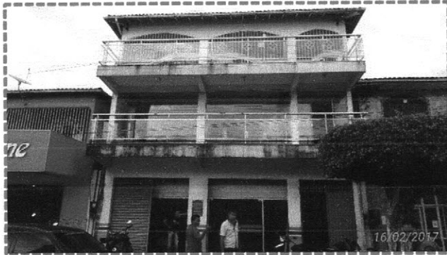
Foto 01: Fachada principal do imóvel
