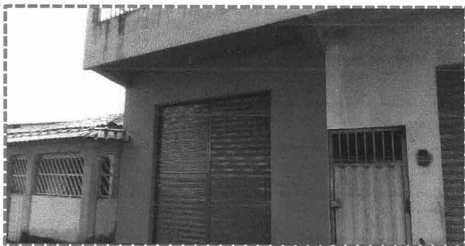
Foto 01: Fachada principal do imóvel
